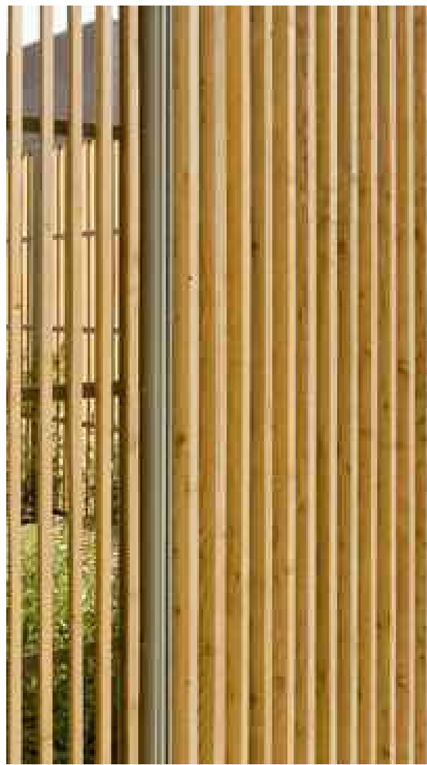
Le facciate - Rivestimento metallico a diversa foratura e facciata con listelli in legno
