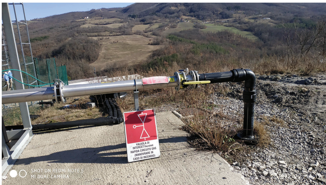
Foto 7: Particolare della valvola di chiusura gas
