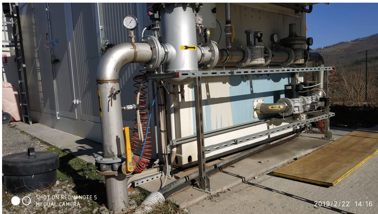
Foto 9: Particolare della valvola di chiusura solo motore
