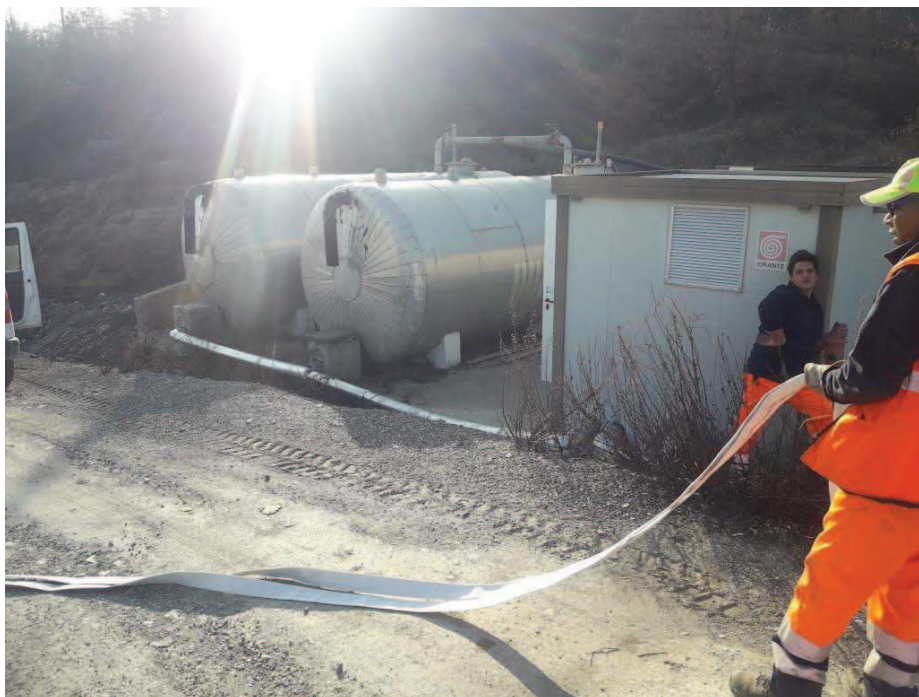
Foto 1 Serbatoio "TORRE FARO" e container con innesco automatico
