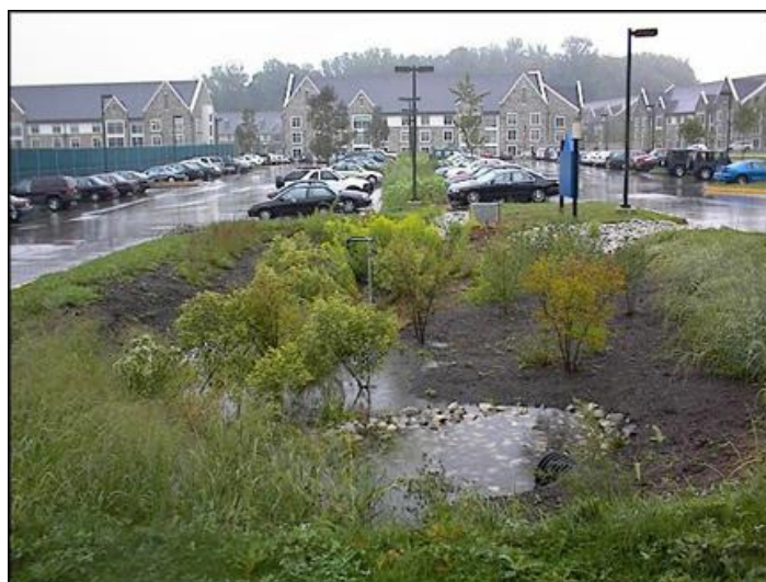
Figura 3.26 – Bacino d'infiltrazione realizzato in un parcheggio pubblico [ http://155.247.107.222/tvssi/ ]
